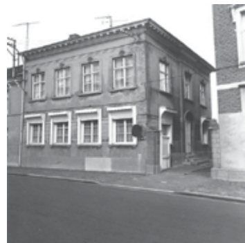
Figuur 15. Toestand in 1977, inventaris bouwkundig erfgoed.
