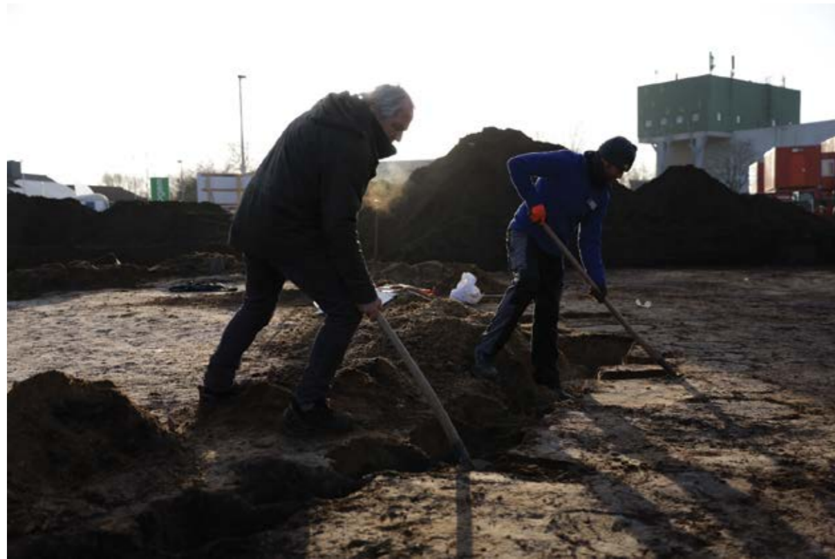
Figuur 5. Het couperen van de paalkuilen.
