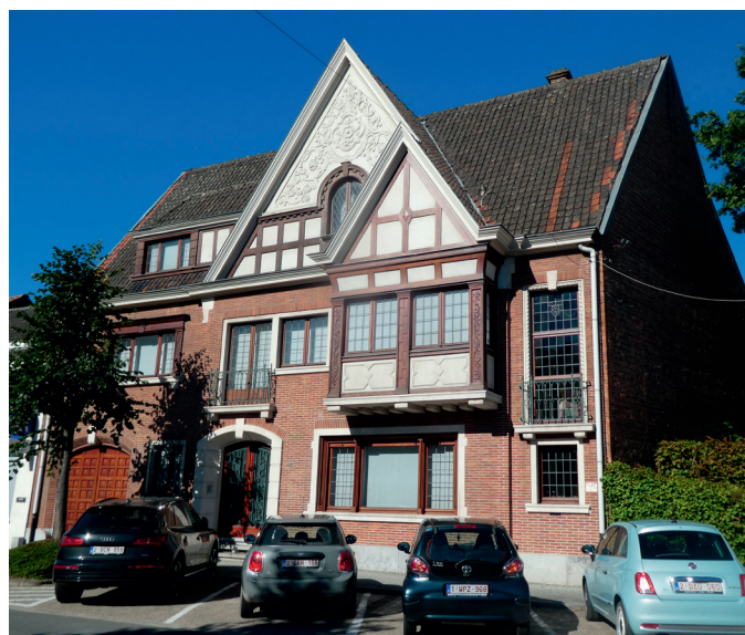
Figuur 63. WO II-architectuur, 1945, Polenlaan.
