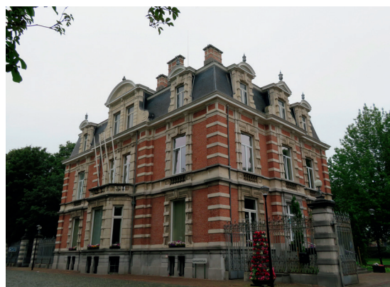
Figuur 46. Kasteel Lippens, Lindenplaats 7 (AOE 2019).
