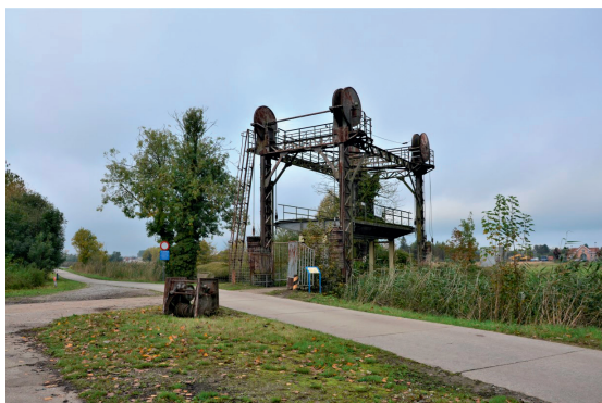
Figuur 52. Vapeurbrug (Erfpunt 2020).
